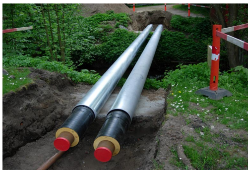
Udskiftning af hovedledning over Brande å.
