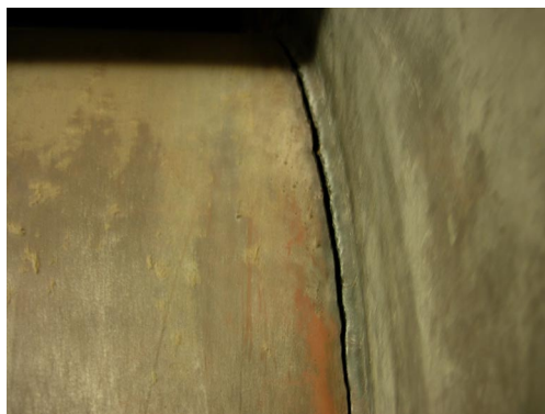
Revne i lyddæmper
